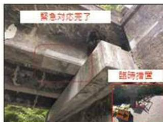
主桁下面の断面修復(通天橋)
